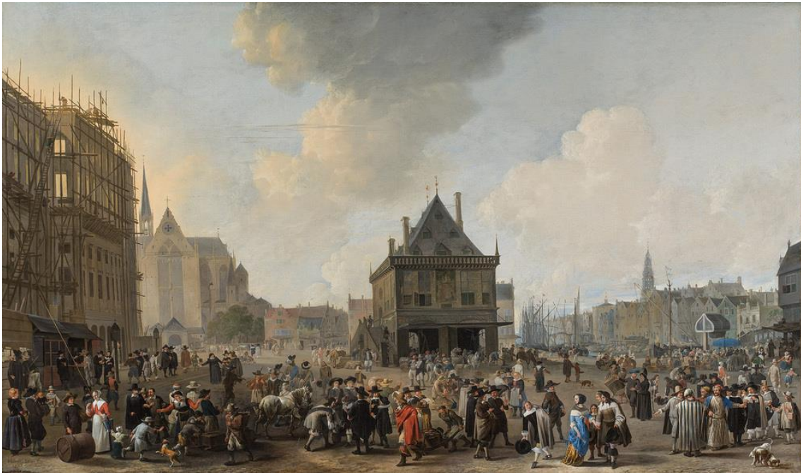
Johannes Lingelbach - De Dam, gezien naar het Noorden, met het Stadhuis in aanbouw (1656) AM Collectie online | Details |
